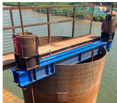
图7 钢吊箱下放系统安装
