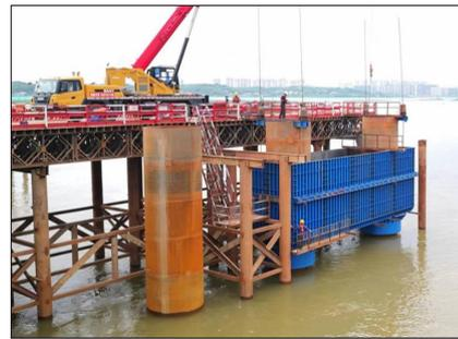
图6 钢吊箱围堰施工过程照片
