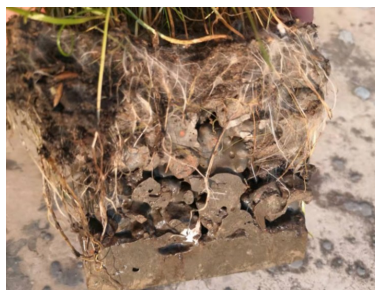
图18 植物根系穿过生态混凝土(50 d)
