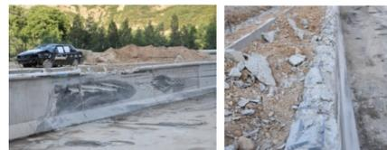
(d) 大型货车碰撞有种植土混凝土护栏损坏
