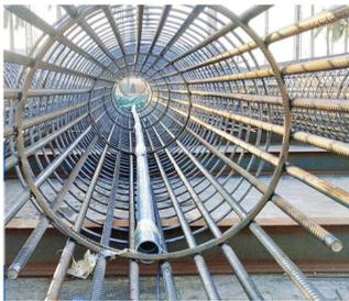
图4 桩体水平位移监测设备
