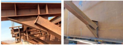
图8 管板连接示意图
