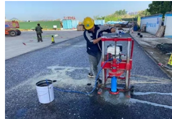
(a) 组合结构全厚度钻芯取样
