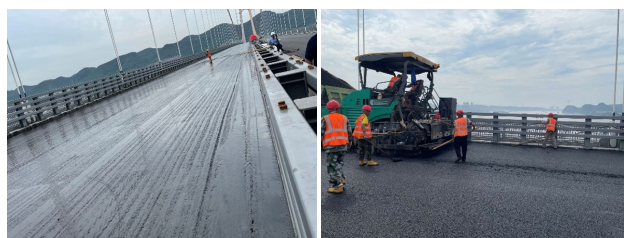
图11 二阶热固性环氧沥青黏结层在宜昌伍家岗长江大桥上应用
