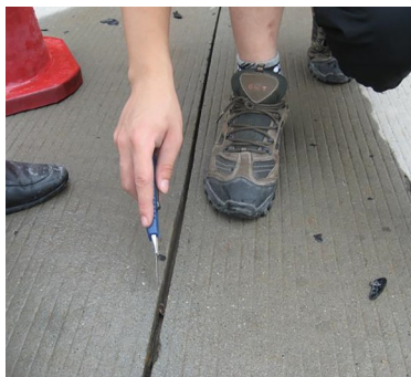
图 2 原水泥混凝土路面接缝
