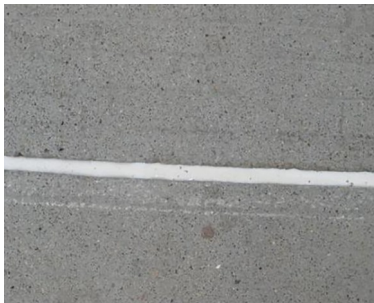
图4 新型填缝料施工效果图
