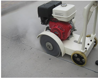
图3 原接缝清缝
