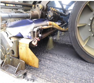
图6 喷洒再生剂
