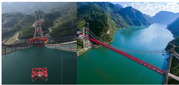
图 7 跨缆吊机带梁行走吊装主梁照片
