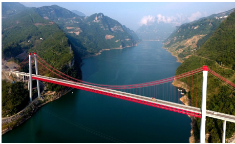
图1 巴东清江特大桥实景图
