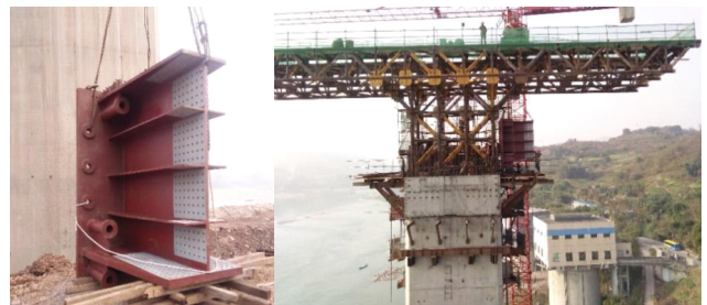
图 5 塔梁固结段及预埋段定位劲性骨架
