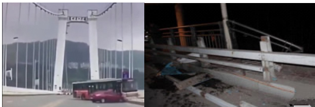
图 1 车辆穿越护栏事故
