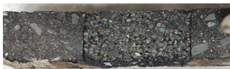
(a) 热拌沥青混合料修复
