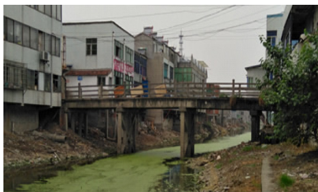
图 1 桥梁现场立面照
