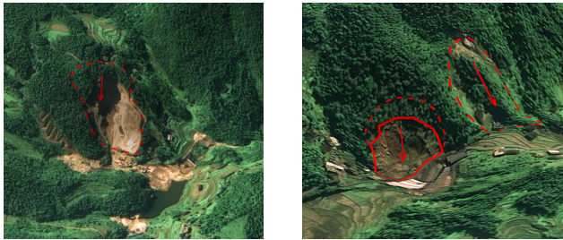
图 2 湖南资兴市 S1 813 线沿线崩塌判识图
