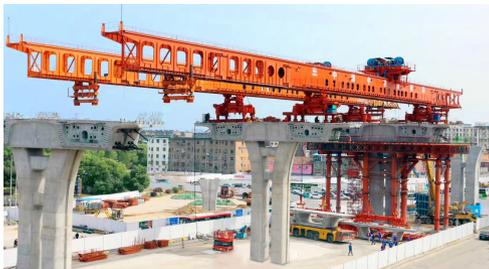
图17 双幅同步架设施工
